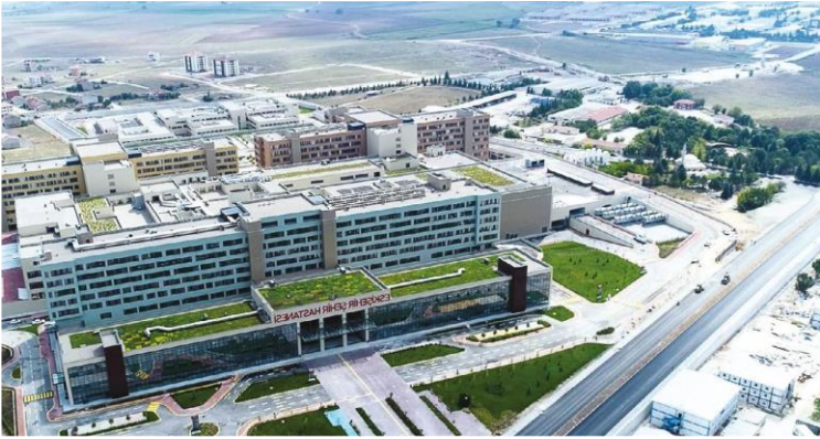
ESKİŞEHİR ŞEHİR HASTANESİ Kapalı Alan: 333.000 m 2
