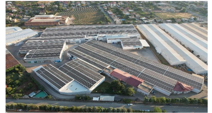
ENSAR TEKSTİL ÇATI GES DC GÜÇ: 4.213,238 kWp
