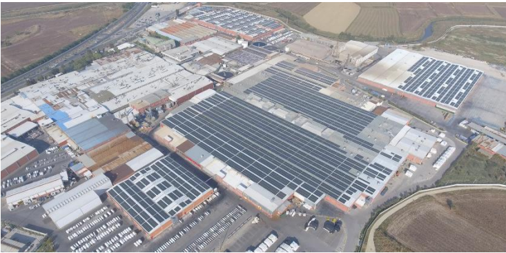
MENDERES TEKSTİL ÇATI GES DC GÜÇ: 7.877 kWp
